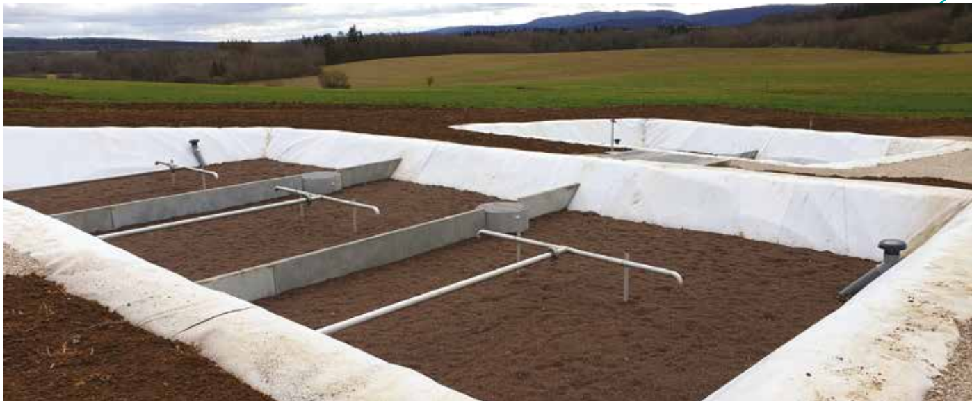
Les premiers travaux ont débuté, ici construction d'une station de traitement des eaux usées.
