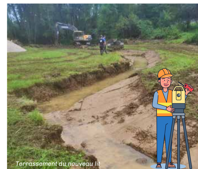
Vue d'une partie du linéaire
