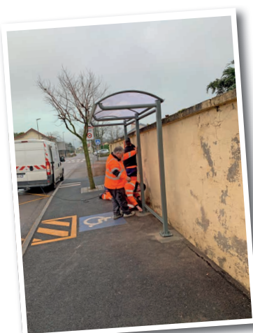
Pose de l'abri-bus Rue Du Château Brun
