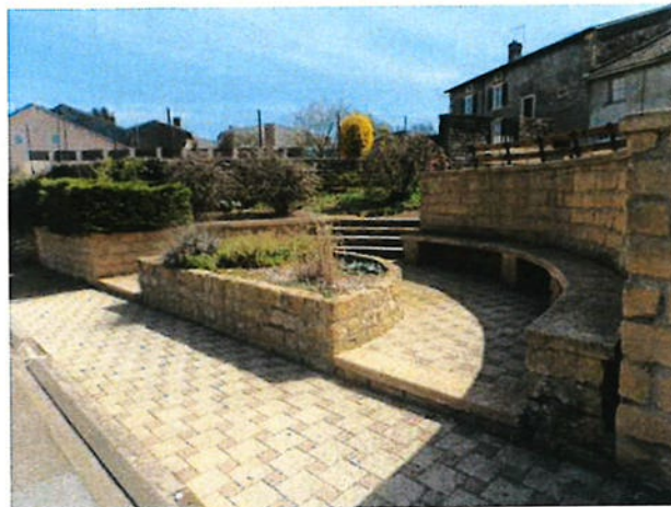
Espace public à Fermont (Grande Rue)
