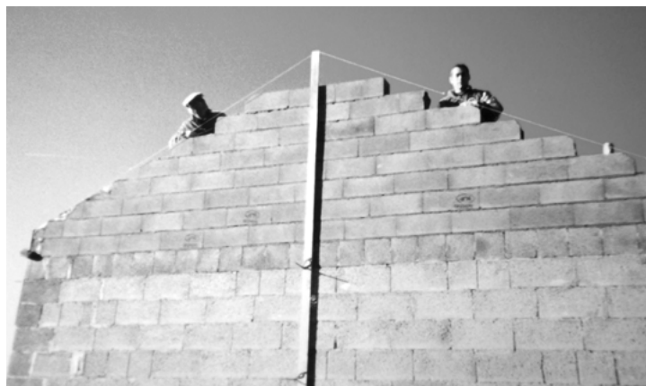
Construction des vestiaires par Joseph et Jean-Marie Pierret.
