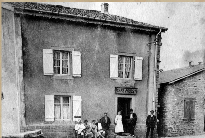
Ancien café Probst avant sa destruction dans l'incendie
