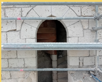
Une porte en ogive donne accès à la terrasse
