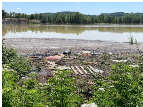
Entrée de l'aqueduc du Page
