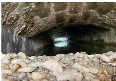
Siphon gauche sous VNF
