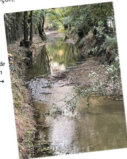
← Siphon gauche de l'Auvignon sous le canal après curage
