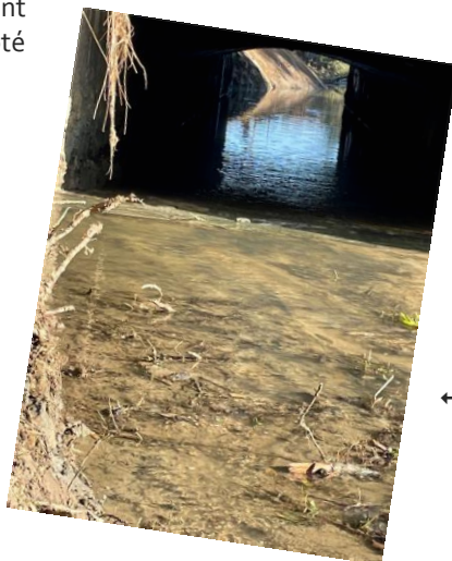
Lit de l'Auvignon en amont du pont de Bruch après entretien
