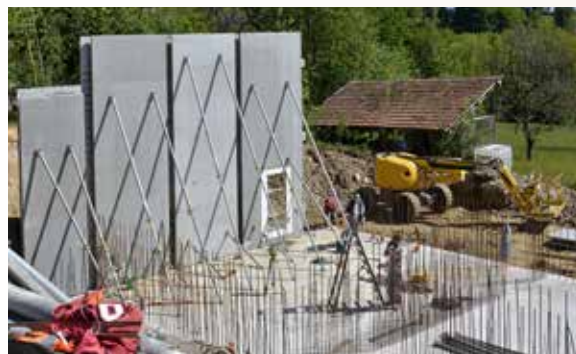
La chaufferie bois en construction
