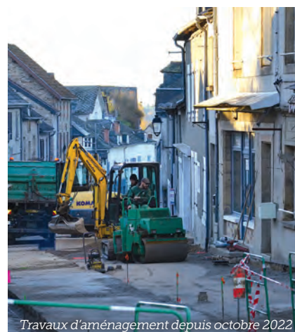
Travaux d'aménagement depuis octobre 2022
