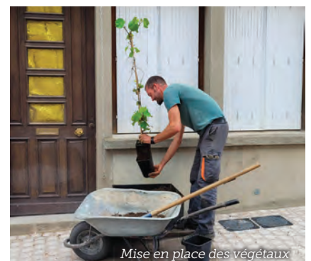
Mise en place des végétaux
