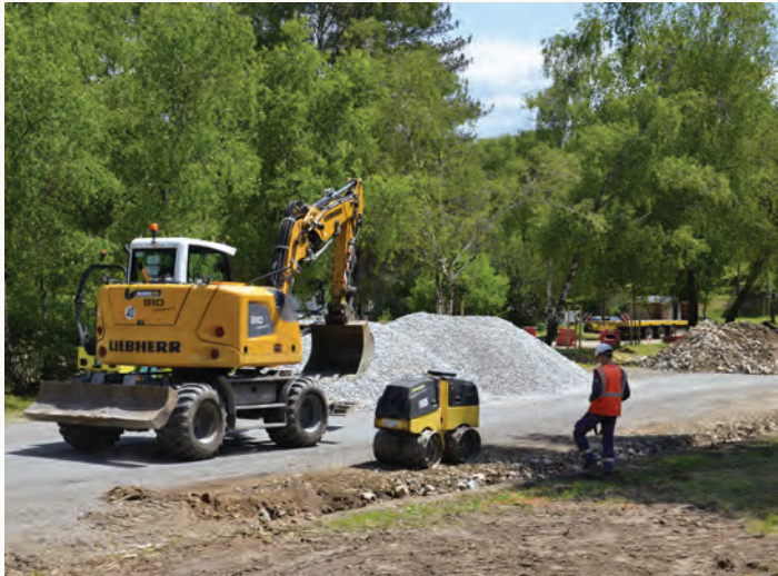
Travaux d'agrandissement du parking à Miel
