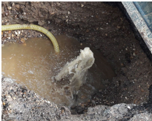
Vue haut de fouille d'une réparation de fuite sur vanne
