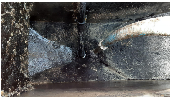
17/03/2022 Nettoyage du dégraisseur
