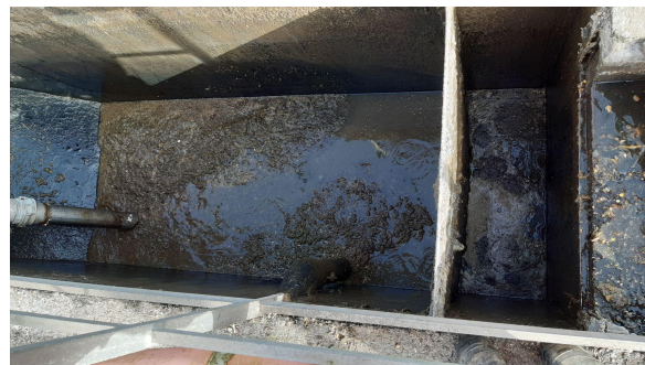
- 17/03/2022 Nettoyage dégraisseur
