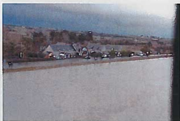
Les Nielles : la digue provisoire en eau
