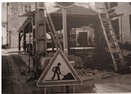
Les travaux entrepris aux lavoirs de la place de la Source ferrugineuse et de la place Piza sont presque terminés. (photo M. Grosboillot, avril 1998)
