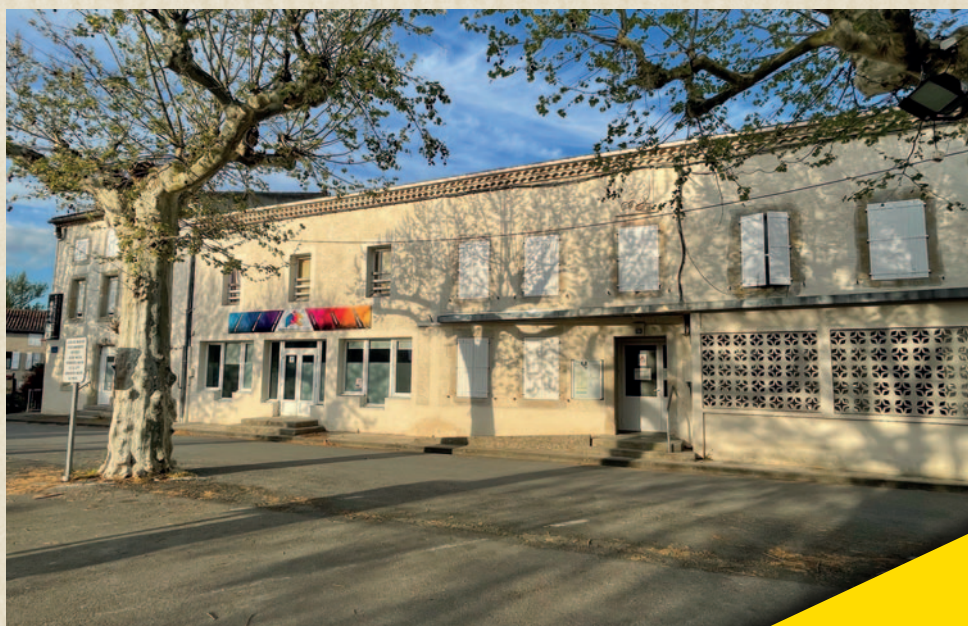
Ravalement de la façade de la MJC
