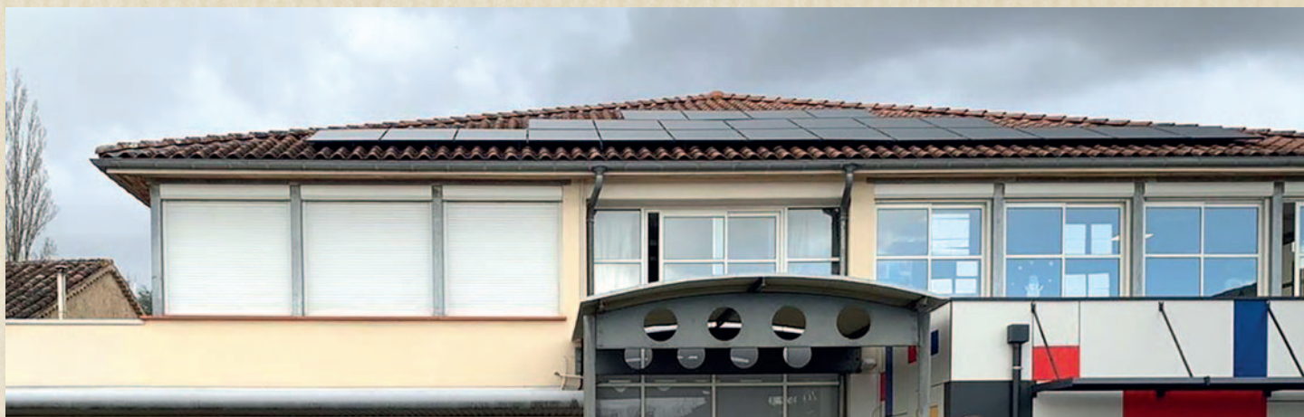
Toiture de la cantine scolaire
