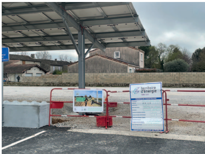
Création du parking « rue des écoles » avec une ombrière
