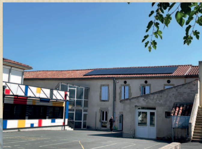
Toiture de l'école
