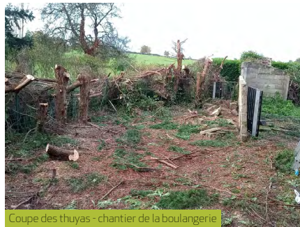
Coupe des thuyas - chantier de la boulangerie
