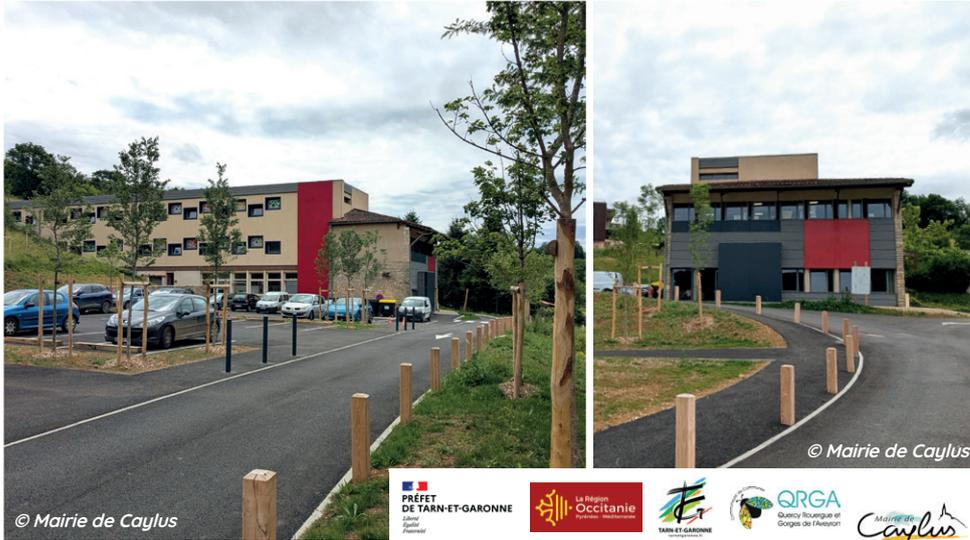
La première tranche de travaux sur les abords extérieurs de l'école communale est finalisée. Cette phase a permis de résoudre les problèmes d'accessibilité et sécuriser les accès par la réalisation d'une voie en sens unique, d'une aire de stationnement (recyclant une zone déjà artificialisée : ancien terrain de sport) et d'un nouveau terrain de sport en contrebas.
