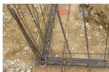
Nœud de chaînage - Continuité mécanique
