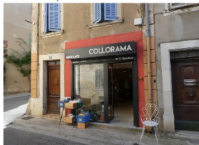
Exemple de devanture mixte avec la vitrine en feuillure et le bandeau horizontal de l'enseigne en applique : composition acceptable conditionnée par la hauteur de la baie. L'enduit de couleur rouge périphérique devrait être supprimé au profit de l'enduit de la façade globale.
