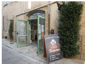
Exemple de devanture en feuillure correcte, hormis les ouvertures à double battant sur l'espace public gênant la circulation piétonne sur le trottoir déjà bien étroit.
