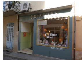
Exemple de devanture en applique effectuée avec un matériau synthétique et brillant non compatible avec les enduits de façade : un ton mat aurait été préférable. Le climatiseur devrait être intégré dans le bandeau horizontal de l'enseigne.
