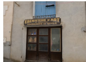
Exemple de devanture ancienne en feuillure et menuiserie bois. À conserver en cas de réhabilitation.
