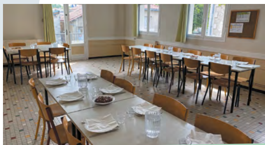
Amélioration du restaurant scolaire de l'école Jules Ferry. Rénovation d'une des salles de restaurant durant les vacances d'avril. Ces travaux (peinture et boiseries) réalisés par les agents municipaux permettent de proposer un cadre plus agréable. Les autres salles seront rénovées durant l'été.
