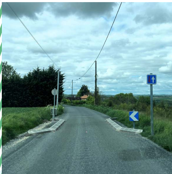
Aménagement de chaussées
