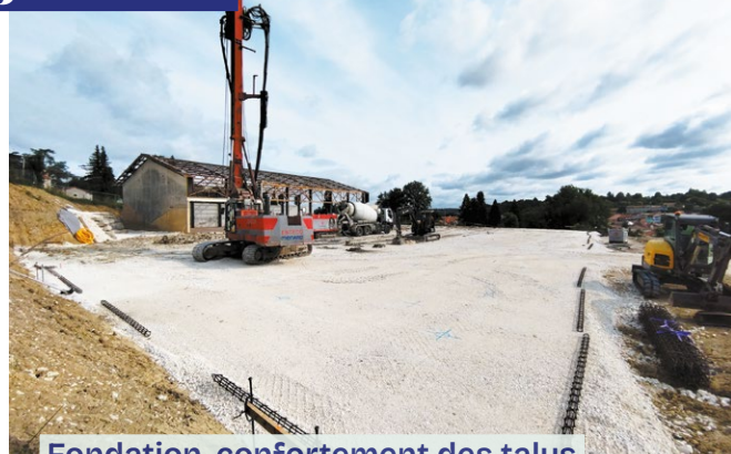
Fondation, confortement des talus et passage des réseaux en sous-dalle.
