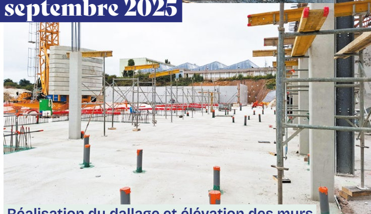
Réalisation du dallage et élévation des murs.
