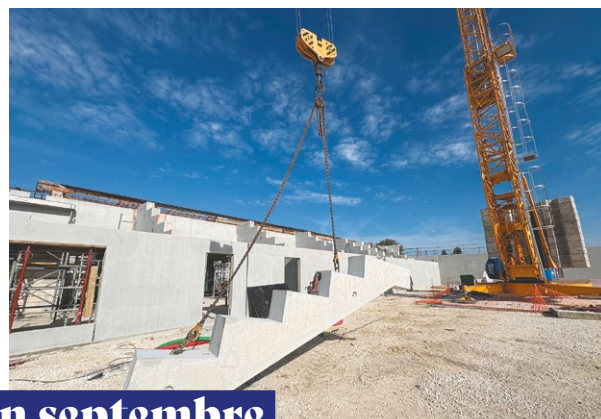
Réalisation du dallage et élévation des murs.
