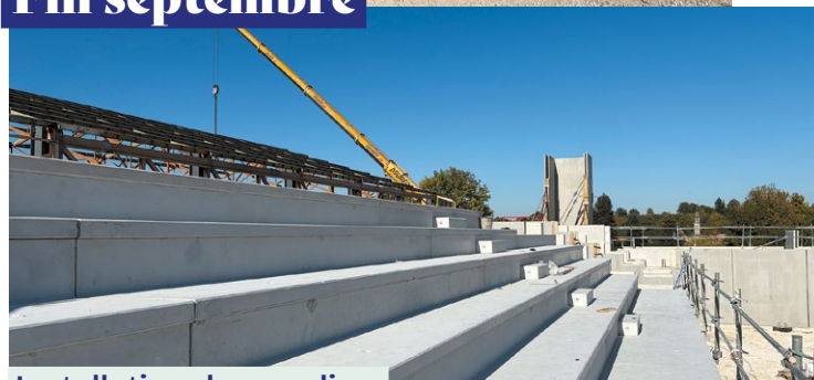
Installation des gradins.
