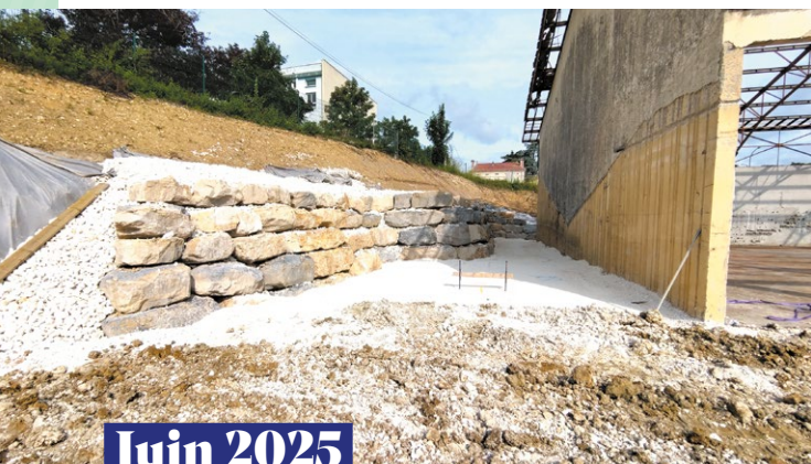
Travaux de terrassement du nouveau bâtiment.
