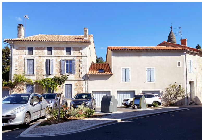
Aménagement place Alsace-Lorraine
