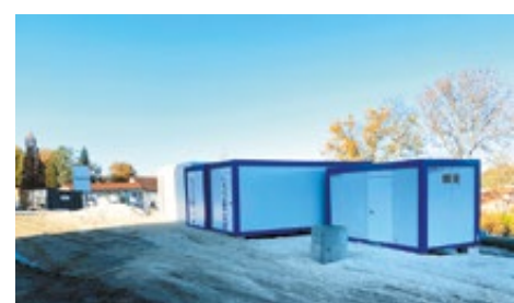
Mise en place de la « base vie » pour le personnel intervenant sur le chantier (vestiaires, sanitaires, salle de pause et espace pour les réunions de chantier).
