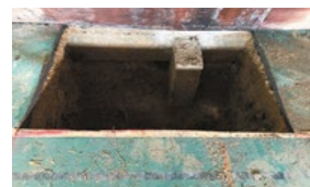
Création des fondations pour les renforcements de la charpente métallique (dans la partie conservée du gymnase).
