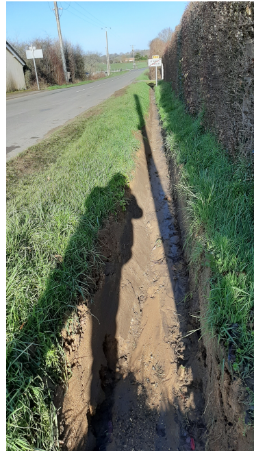
Curage des fossées à La Grouas
