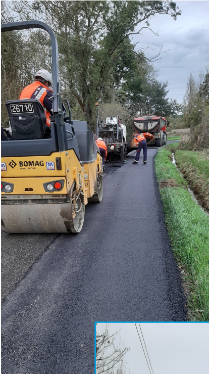
Rénovation de la route de Venerais.
