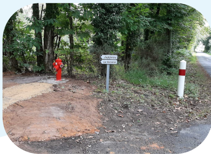
Installation de bornes d'incendie à la Grande Oisellerie et aux Vénerais
