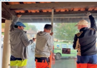
Démontage abri bus pour mise en sécurité
