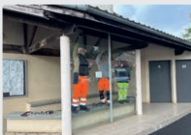
Démontage abri bus pour mise en sécurité
