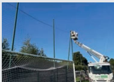
Remise en place du filet de protection stade de football
