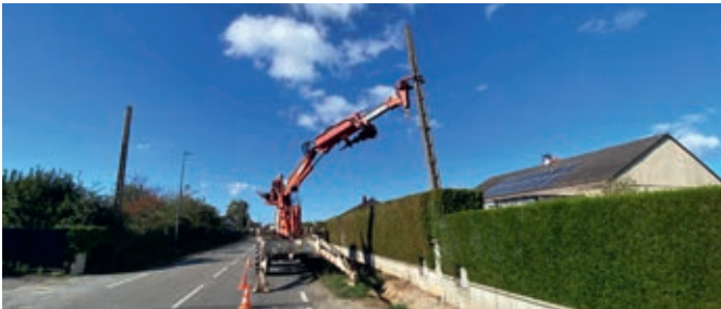
Effacement des réseaux électrique et téléphonique rue de Limoges
