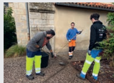
Nettoyage parterre église
