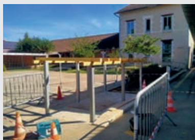
Pose d'un rack à vélos ALSH
