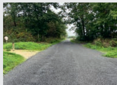
Réfection route Chemin des Granges
