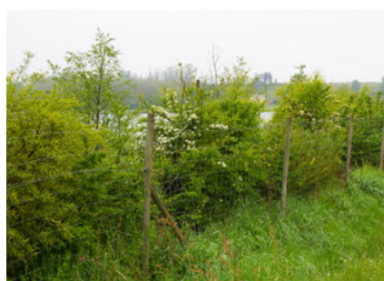
grillage souple et poteaux bois + haie champêtre
