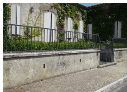
muret soubassement, grille + haie
