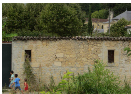
mur d'enceinte protégé de tuiles
