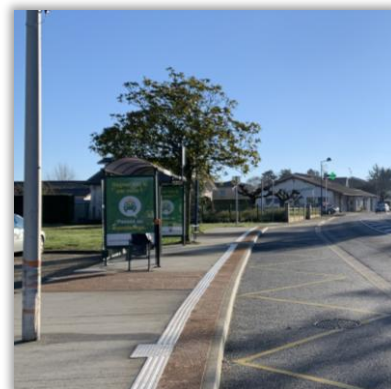
Mise en accessibilité de l'arrêt de transport collectif
