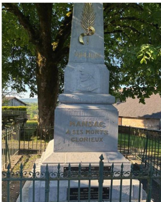
Le monument aux morts de Mansac a été décapé par la technique de l'aérogommage. Cette prestation a été réalisée par la société écodecap19.
