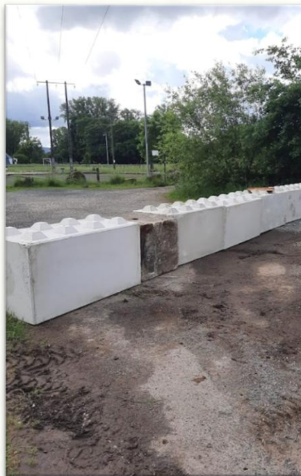
Sécurisation des stades par l'installation de BBlox
