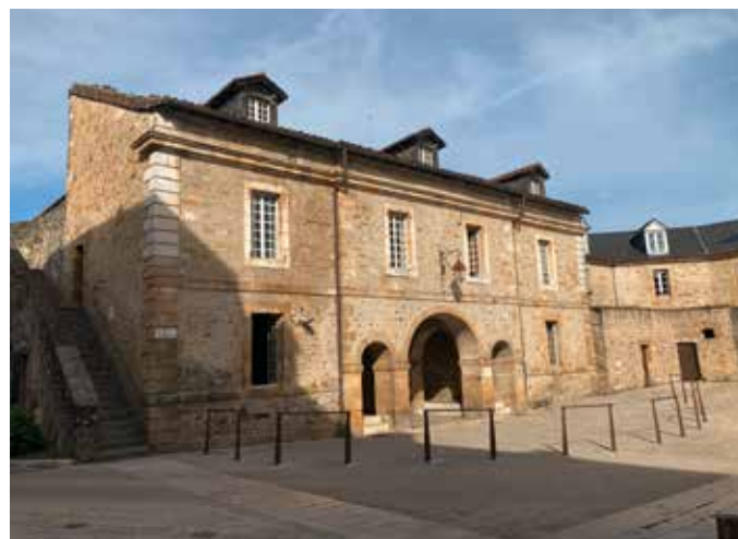
La porte Saint Antoine, un bâtiment historique pour lequel la dégradation de la toiture compromet sa vocation de soutien à l'art ou l'artisanat.
