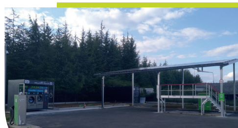
Station de lavage après rénovation et Kiosque «Ma petite Laverie»
