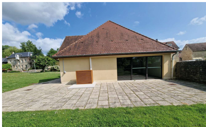
La nouvelle pompe à chaleur, située à l'arrière de la salle.
