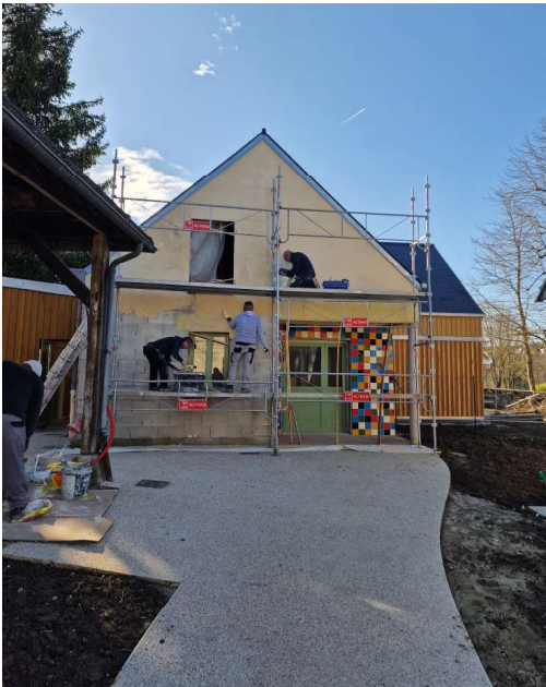
Le pignon d'entrée en phase de crépissage
