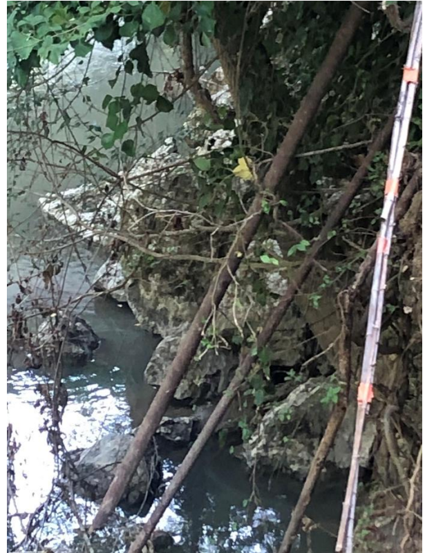
L'empierrement protégeant le pont, déstabilisé.
