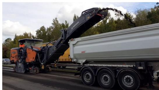
*Illustration d'une raboteuse de chaussées en action, en train de produire des agrégats d'enrobés*
