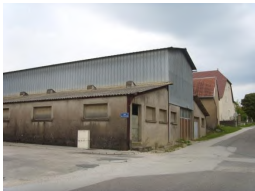
Bâtiments agricoles au niveau du bourg-centre
