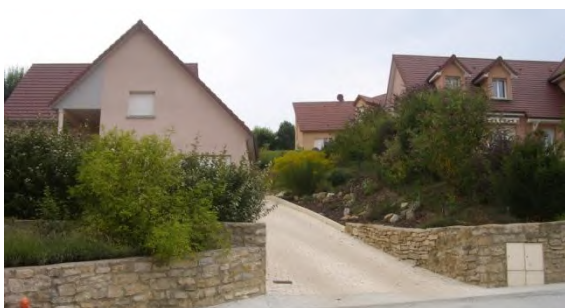
Constructions récentes surplombant la RD465
