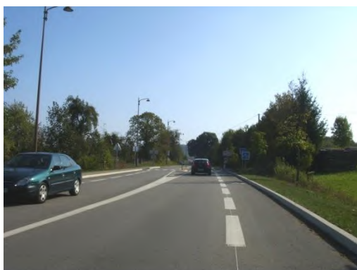
Entrée Ouest de Pouilley-les-Vignes, au niveau de la RD70
