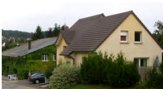
Construction récente à proximité d'une ancienne bâtisse
