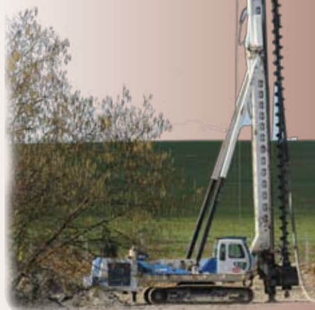
Les pieux ont été réalisés à la tarière creuse à l'aide de cette machine.
