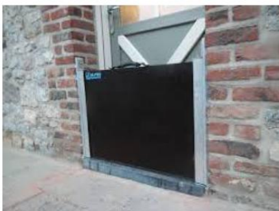
Figure 125 : Exemples de batardeaux amovibles ou de portail contre les inondations
