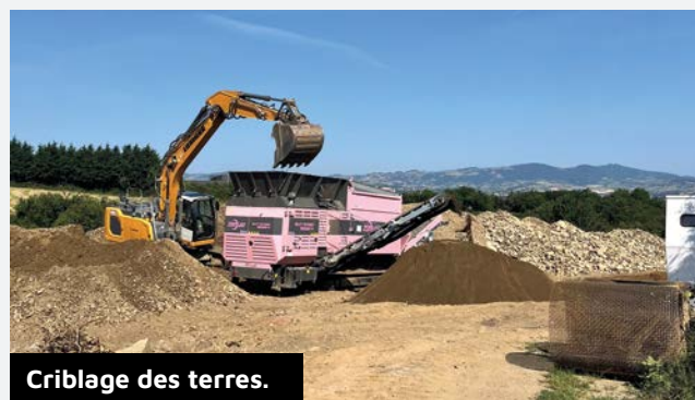
Chantier en cours.
