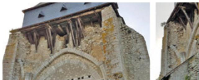
certaines charges poinçonnent les claveaux de l'arc plein cintre en maçonnerie.
