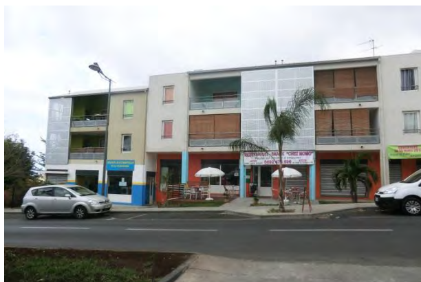
Commerces en rez-de-chaussée – Avenue Salvador Allende
