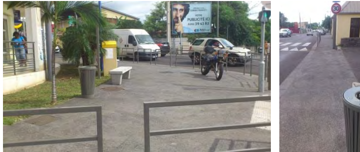
Aménagements sécurisés pour piétons rue des Lataniers
