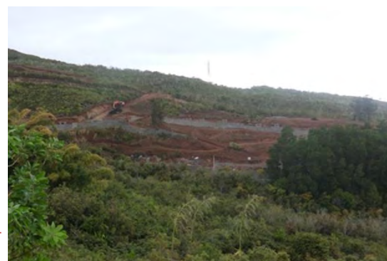
Opération en cours en flanc du massif forestier
