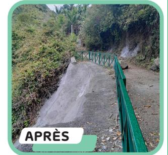
Consolidation du talus aval de la partie piétonne du chemin Ratinaud : réalisation d'une paroi en béton projeté avec armature d'acier et clous d'ancrage.
