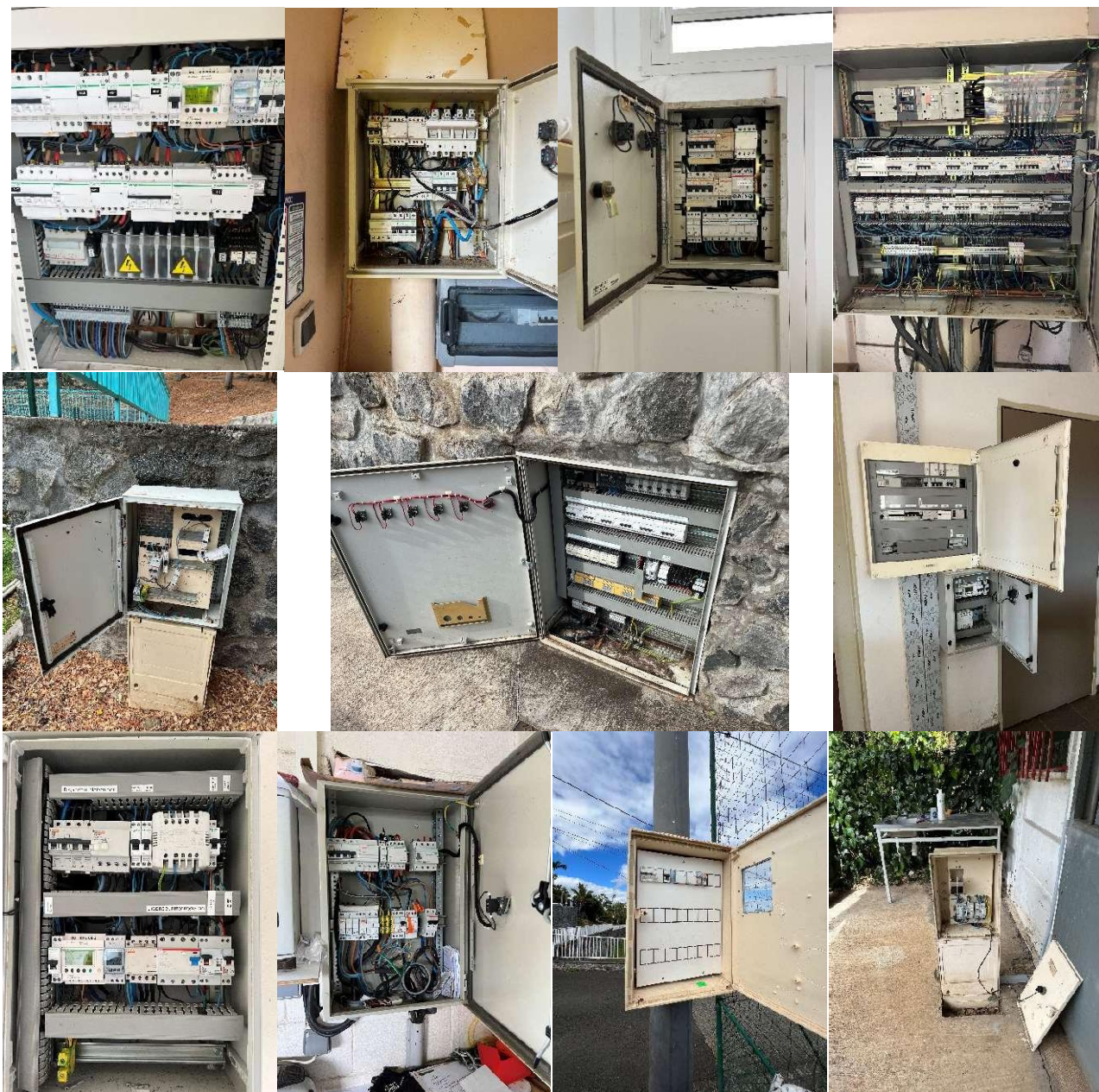
Exemples d'armoires éclairage sportif relevées
