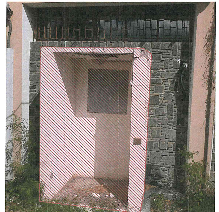
4- Porte murée existante à ouvrir
