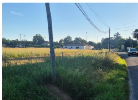
Extension du réseau d'assainissement collectif Grand rue de Lunel
