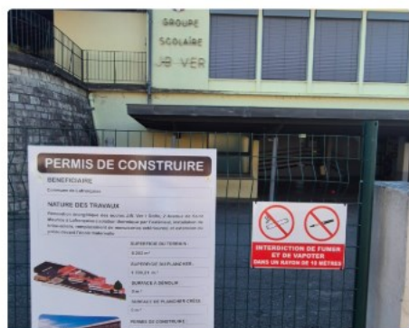
Rénovation énergétique de l'école JB Ver-Dolto
