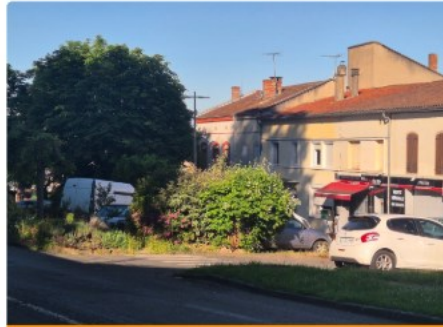
Enfouissement des réseaux et reprise de l'éclairage public Place Midi-Pyrénées
