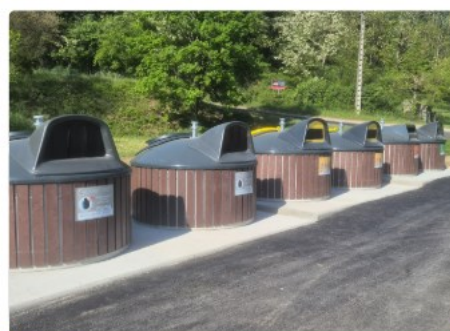
Enfouissement des colonnes ordures ménagères Côte St Georges
