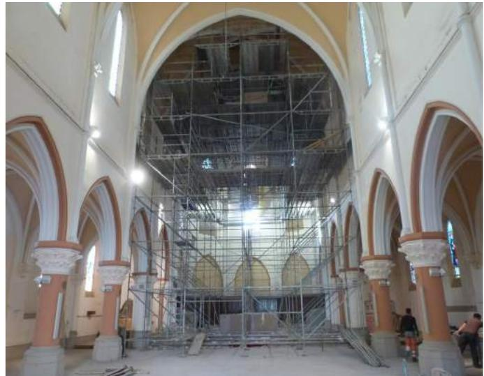
La première phase des travaux pour la mise en sécurité et la rénovation de l'église St Georges a été réalisée entre novembre 2016 et mars 2017. D'un montant total de 154000 € (130000 € pour les travaux et 24000 € études, SPS et maîtrise d'ouvrage), elle a consisté à déposer l'intégralité des voûtes de la nef et des bas-côtés. Cette action visait à sécuriser le site et à alléger le poids que fait peser cette structure décorative sur l'édifice.
