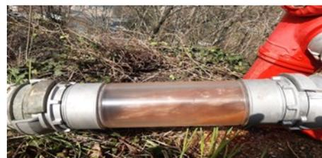
Ce procédé ne fragilise pas les conduites et permet par le biais d'une émulsion eau-air-eau de nettoyer en profondeur le biofilm générateur d'eau trouble ainsi que des particules en suspension. L'air injecté dans le réseau passe par des filtres afin **d'éliminer les poussières, l'eau et l'huile** pouvant être présents afin de ne pas contaminer le réseau traité. Ces filtres sont vérifiés et remplacés.
