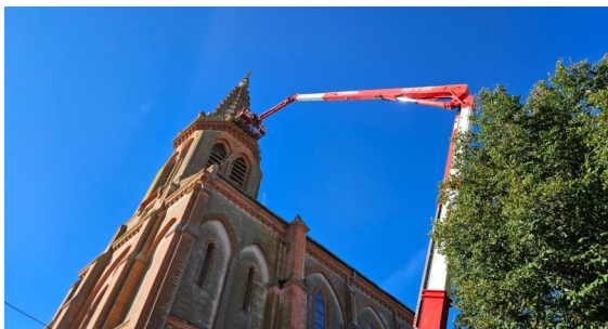
Changement des abat-sons de l'église St Georges Travaux faits en régie Coût : 15 000 €
