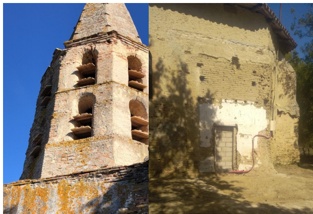
Changement des abat-sons de l'église et démolition de la sacristie de Rouzet. Travaux faits en régie (avant reprise du plafond et du crépi par des entreprises)
