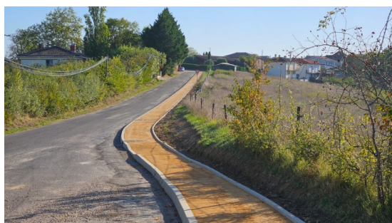
Création d'un cheminement piétonnier route de Lapeyrouse
