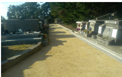
Aménagement et sécurisation de l'allée nord du cimetière de Farguinel
