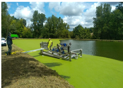
Curage de la lagune 1 - assainissement collectif
