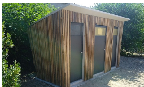
Réfection des toilettes publiques à Lunel (chantier Jeunes). Travaux faits en régie.
